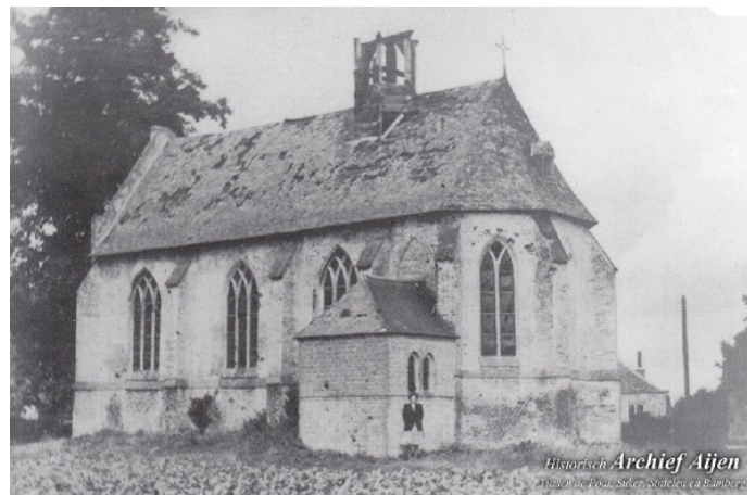
De kapel met oorlogsschade
